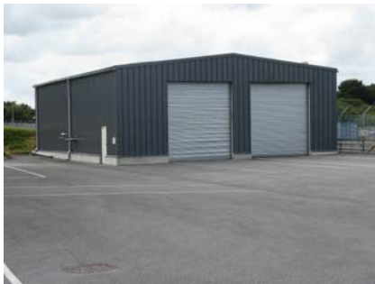
Le local ADR* permettant le contrôle radiologique du camion
