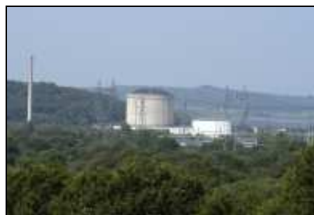
Centrale de BRENNILIS
